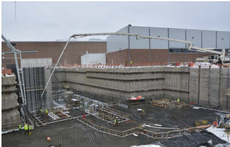
Pour for the tunnel foundation slab
